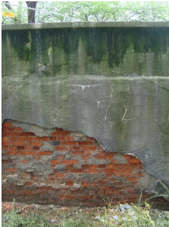
Fot.3 Ubytki tynku oraz korozja materiału konstrukcyjnego ścian bocznych.
