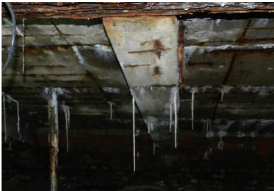
Fot.2 Korozja oraz nacieki substancji mineralnych na spodniej stronie biegów schodowych.
