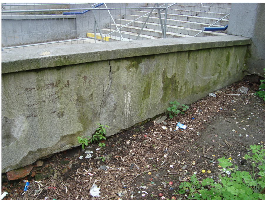
Fot. 7 Widok zwieńczenia ściany bocznej schodów. Widoczny fragment oryginalnego tynku ściany z młotkowaną fakturą oraz żłobkowania bocznych powierzchni zwieńczenia lastryko i tynku pod zwieńczeniem.
