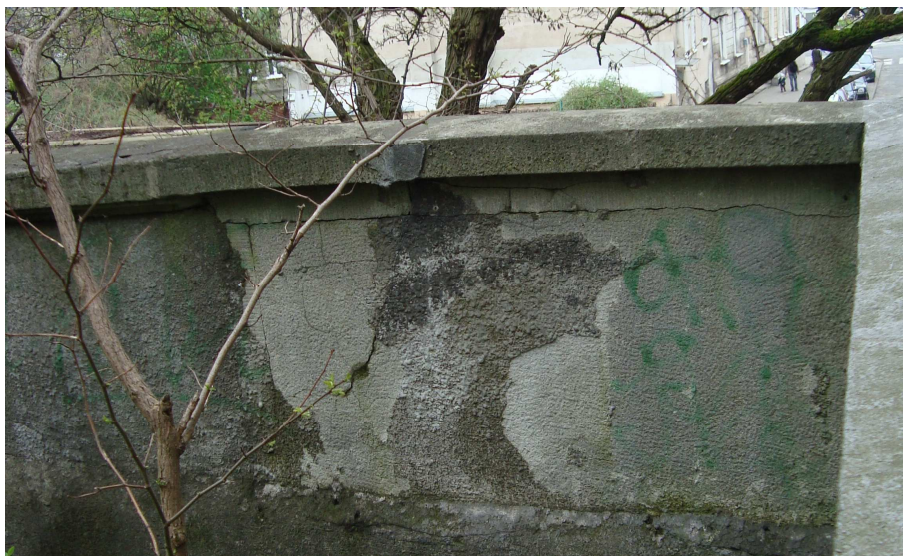
Fot. 6 Widok zwieńczenia ściany na przyporze. Widoczny fragment oryginalnego tynku ściany z młotkowaną fakturą oraz żłobkowania bocznych powierzchni zwieńczenia lastryko i tynku pod zwieńczeniem.
