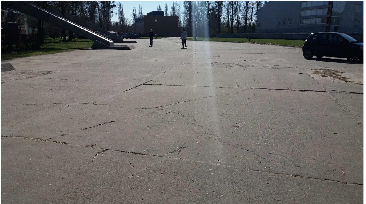
Fot. 13. Teren utwardzony wokół obiektu. Na terenie utwardzonym zaobserwowano pęknięcia płyt betonowych.
