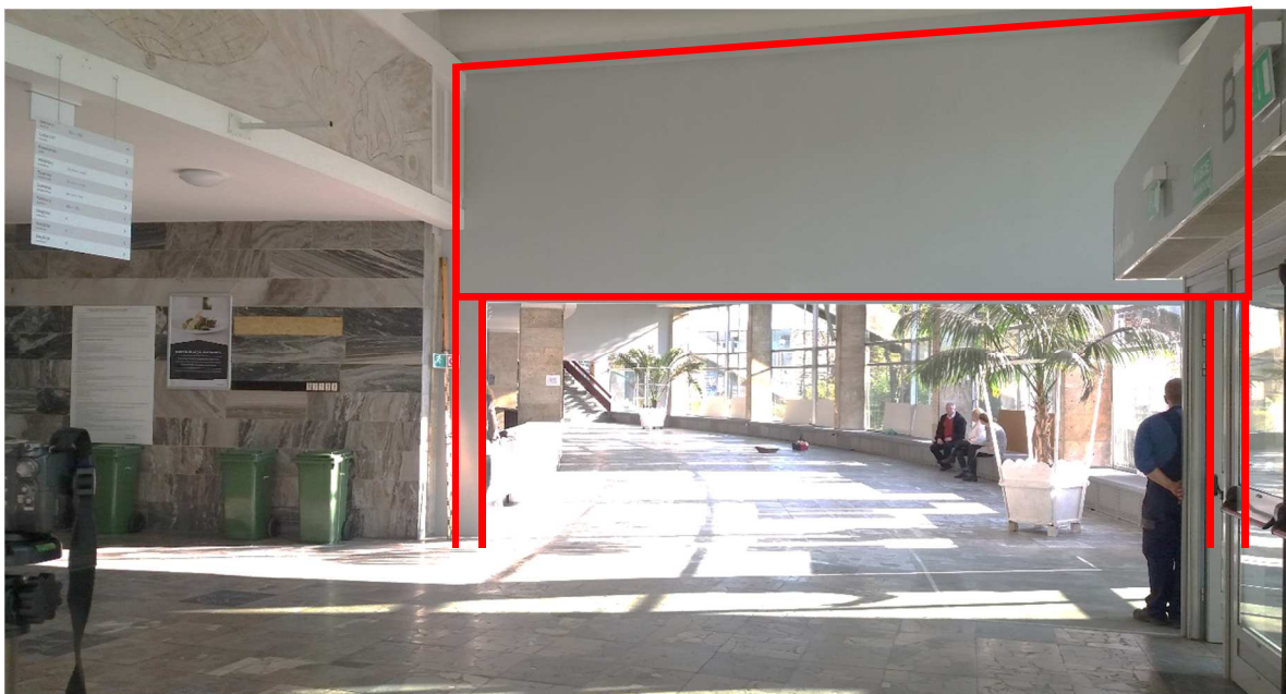
Fot. 11. Foyer oddzielone od drogi ewakuacyjnej z hali do wyjścia B tymczasową przegrodą EI 30 pełniącą funkcję kurtyny dymowej.
