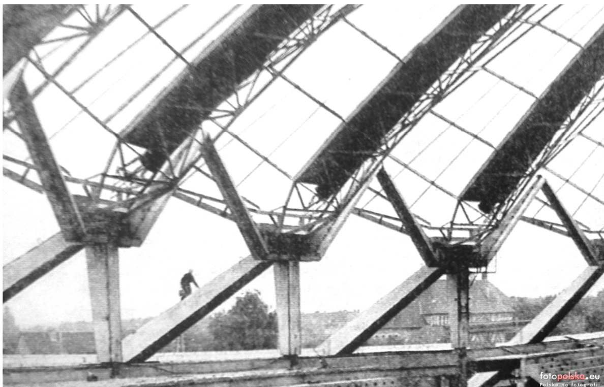
Fot. 5. Zdjęcie z czasów budowy Areny. Konstrukcja stalowa kopuły.
