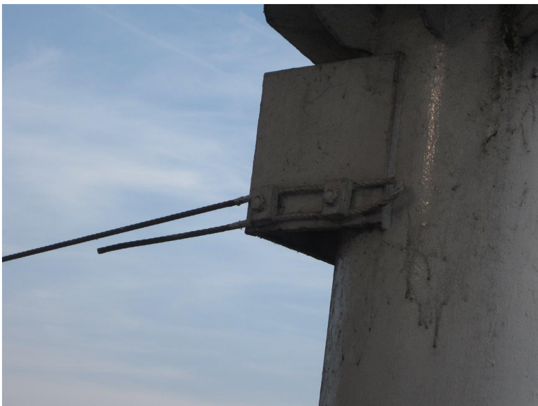
Maszt przy wieży sędziowskiej, widoczne ślady korozji. Mocowanie lin bez zastrzeżeń.
