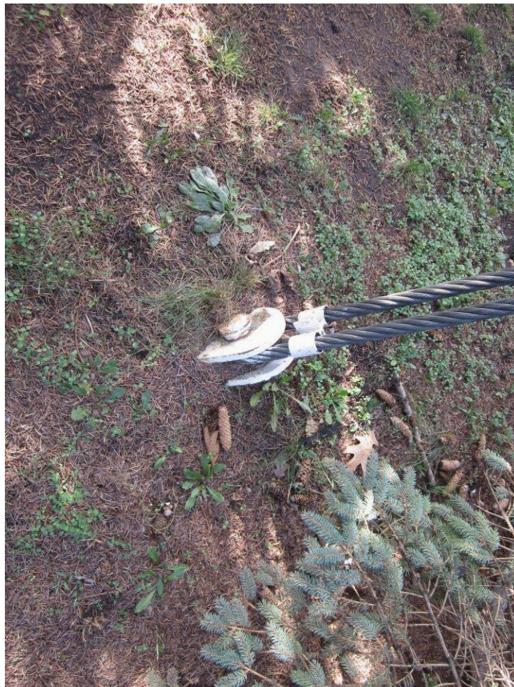
Maszt od strony północnej. Mocowanie lin odciągowych zasypane gruntem. Konieczne odsłonięcie (usunięcie gruntu) i zabezpieczenie antykorozyjne elementów stalowych
