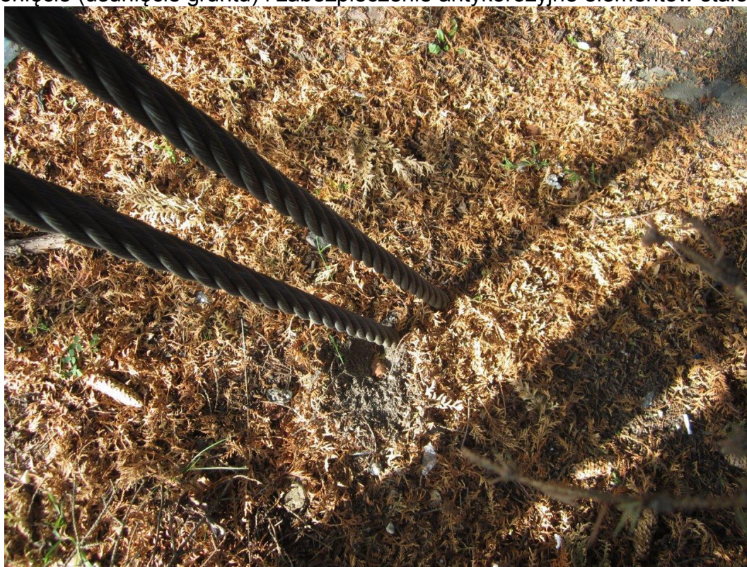
Maszt od strony północnej. Mocowanie lin odciągowych zasypane gruntem. Konieczne odsłonięcie (usunięcie gruntu) i zabezpieczenie antykorozyjne elementów stalowych
