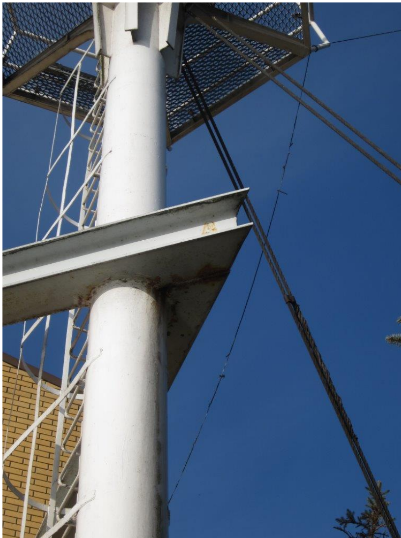
Maszt od strony północnej. Widoczne ślady korozji. Konieczne wykonanie konserwacji powłok malarskich.
