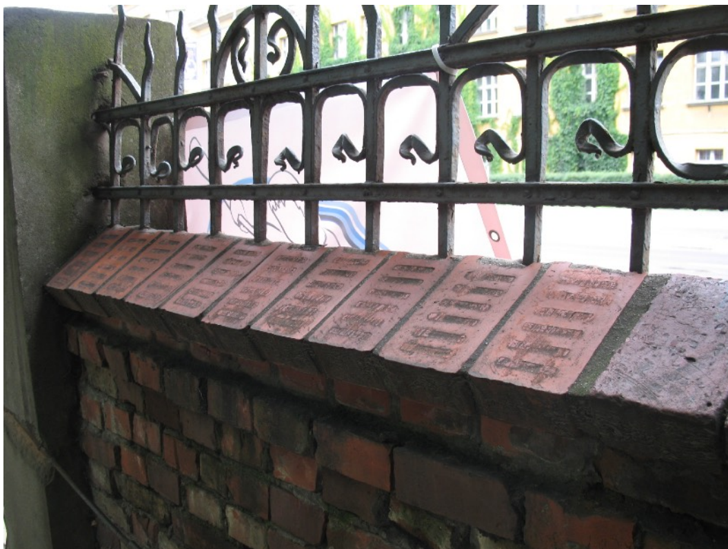
Fot. 23 Wtórny fragment daszku wieńczącego przęsło - wykonany z cegły dziurawki.
