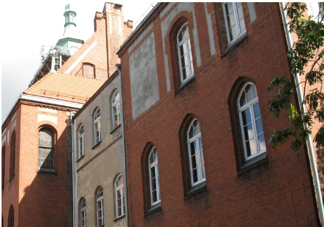
Fot. 15 Nowe tynki płycin skrzydła południowego.
