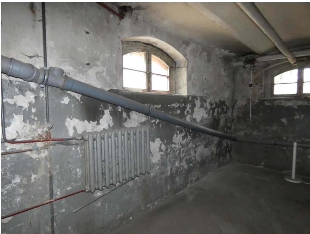
Fot. 31 Pomieszczenia magazynowe z silnie zawilgoconymi i zasolonymi tynkami.
