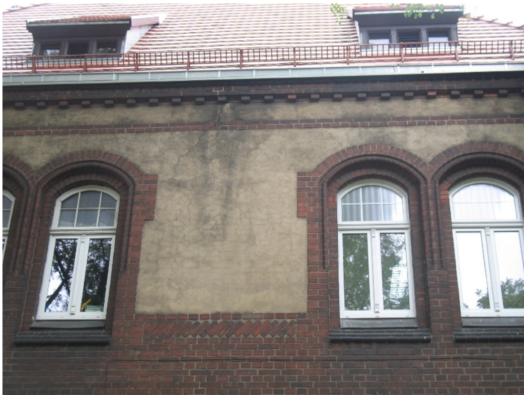
Fot. 13 Stan zachowania tynkowanych płycin - widoczne zabrudzenia i siatka spękań oraz większe pęknięcia.
