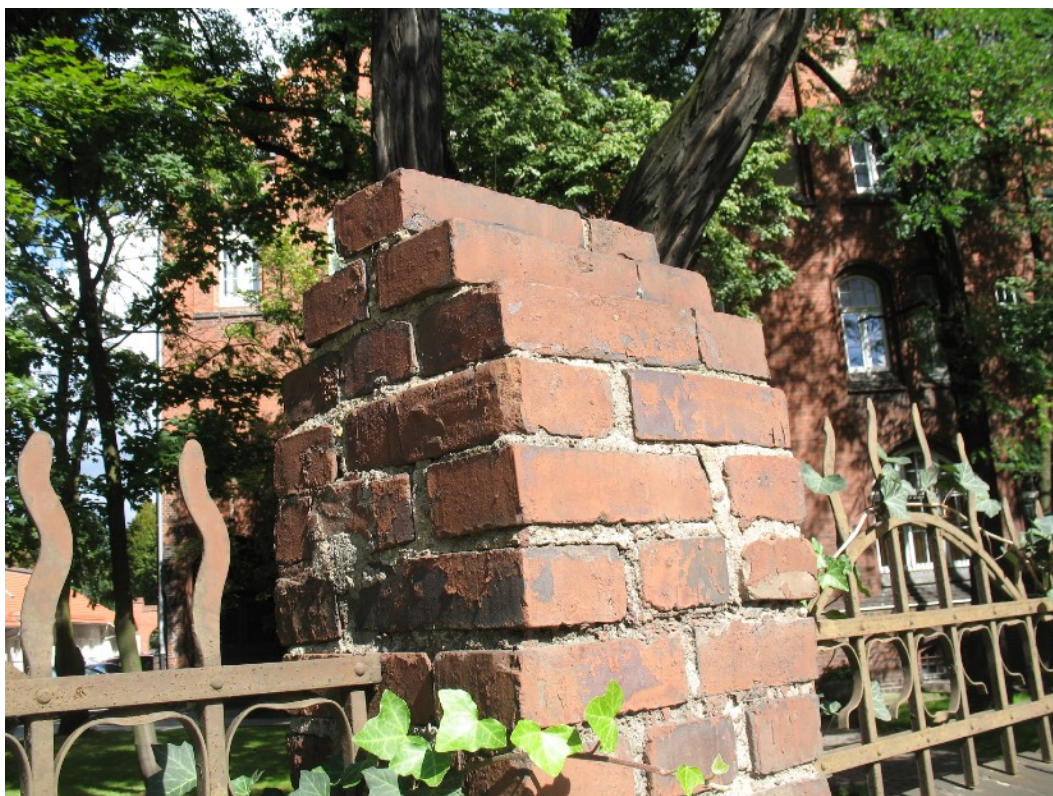
Fot. 26 Przykład niewłaściwych rekonstrukcji czap słupków ogrodzenia. Widoczne również mało estetyczne rekonstrukcje metalowych krat.
