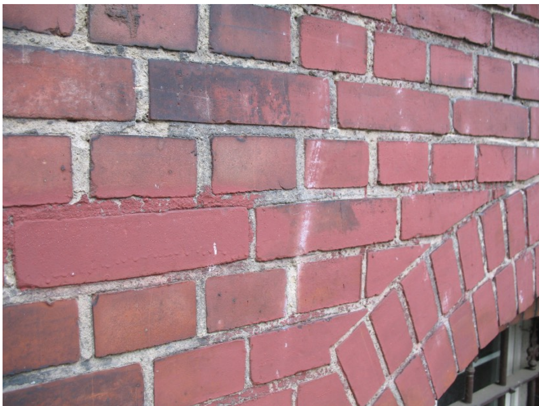
Fot. 16 Nieestetyczne przemalowania cegieł.
