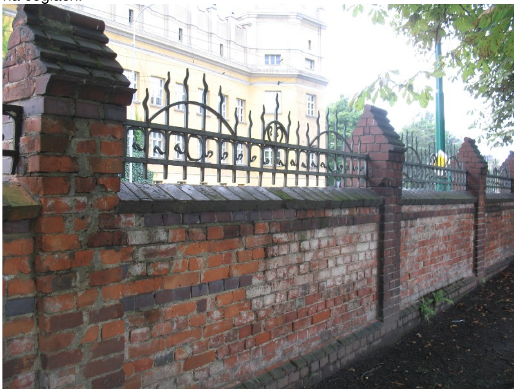
Fot. 18 Fragment ogrodzenia od strony wewnętrznej. Widoczne wysolenia na przęsłach oraz wtórne, nieestetyczne uzupełnienia w wążku na słupku.
