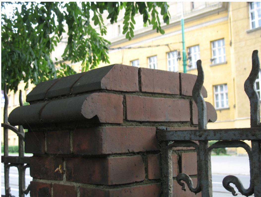
Fot. 25 Przykładowe ubytki w czapie słupków ogrodzenia. Widoczna również korozja krat.
