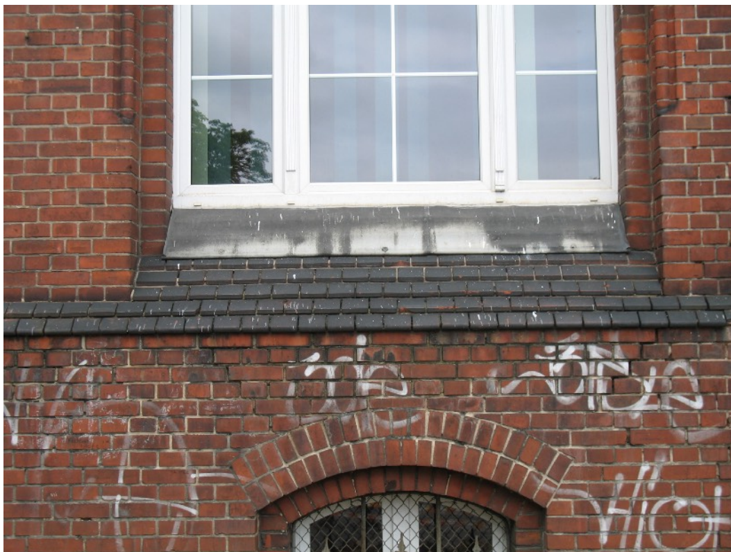
Fot. 7 Zbliżenie na silne zabrudzenia cegły w strefie parapetowej. Widoczne także graffiti oraz wypłukane fugi.
