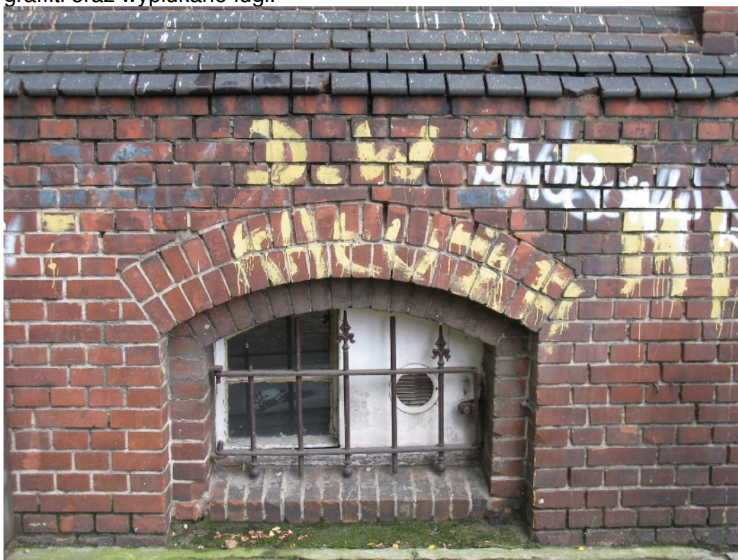
Fot. 8 Zbliżenie na strefę cokołową. Widoczne silne zabrudzenia oraz uszkodzenia kształtek parapetowych, graffiti, wypłukane fugi, porost mikroorganizmów i ubytek w kracie - brak jednej z lilijek.
