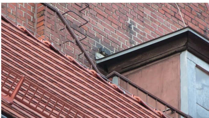
Fot. 15. Zbliżenie na otwór pod drewnianym wykończeniem daszku na elewacji zachodniej.
