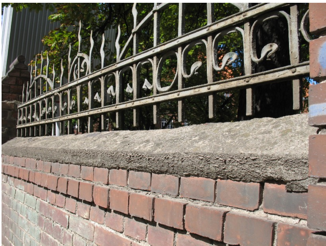
Fot. 24 Betonowa niewłaściwa „rekonstrukcja” daszka wieńczącego przęsło.
