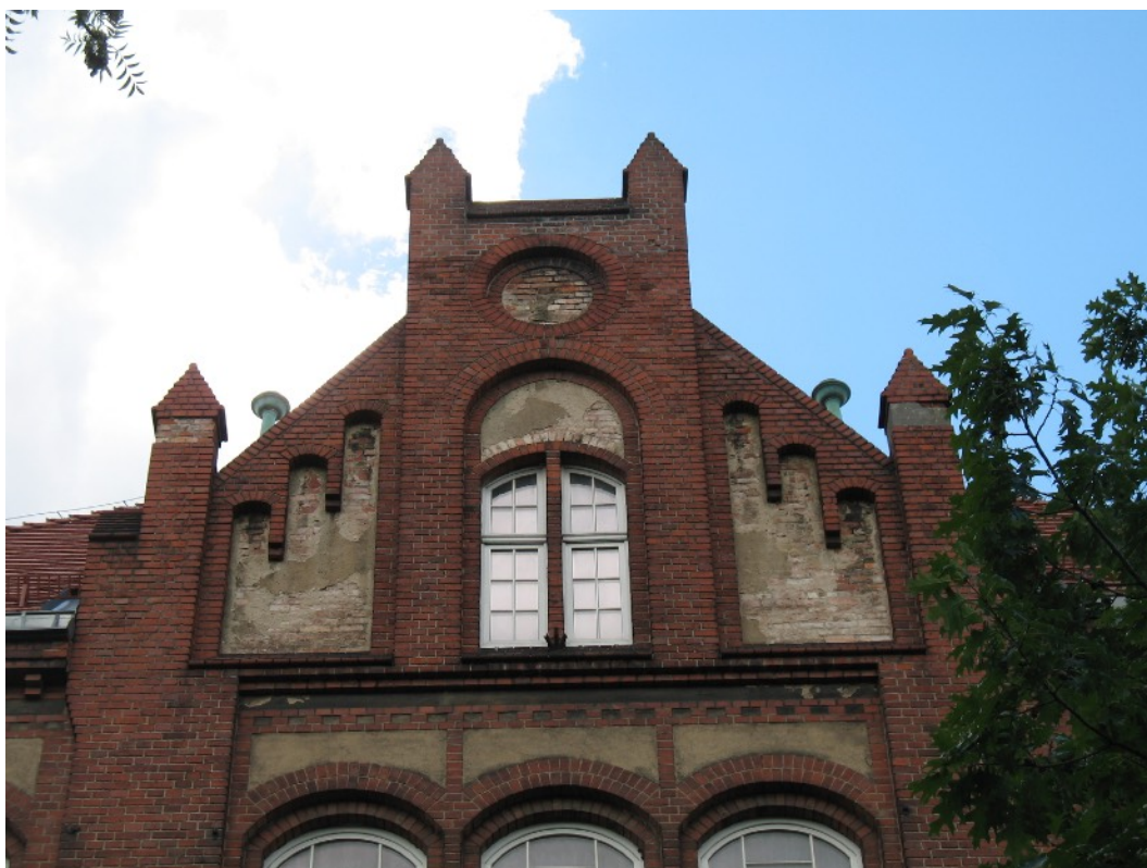
Fot. 14 Stan zachowania płycin tynkowanych na szczycie północnym.
