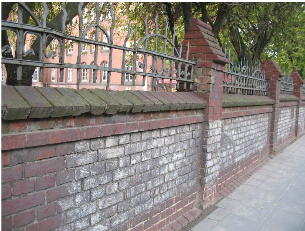
Fot. 17 Fragment ogrodzenia od ul. Bukowskiej. Widoczny porost mikroorganizmów, wygięcia i korozja krat, wtórne, nieestetyczne uzupełnienia na słupku, przemalowania na ceglach.
