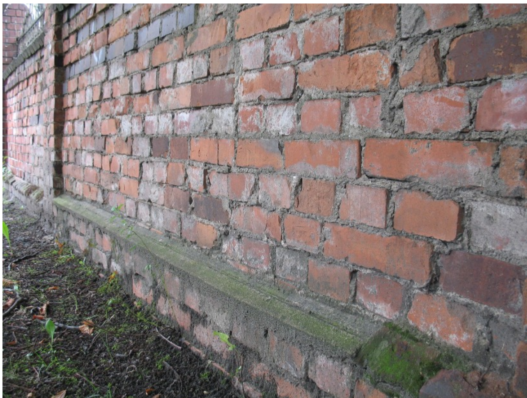
Fot. 21 Brak rolki z kształtek - „cementowa rekonstrukcja”.
