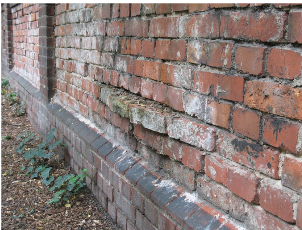
Fot. 22 Przykład wybrzuszenia, wypchnięcia cegieł w przęśle muru.
