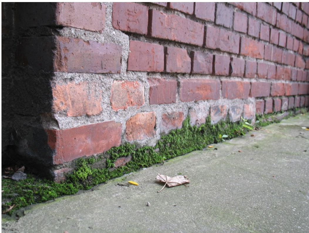
Fot. 11 Nieestetyczne uzupełnienie narożnika, wykonane ze zwykłej cegły oraz porost mchu świadczący o zawilgoceniu strefy cokołowej.
