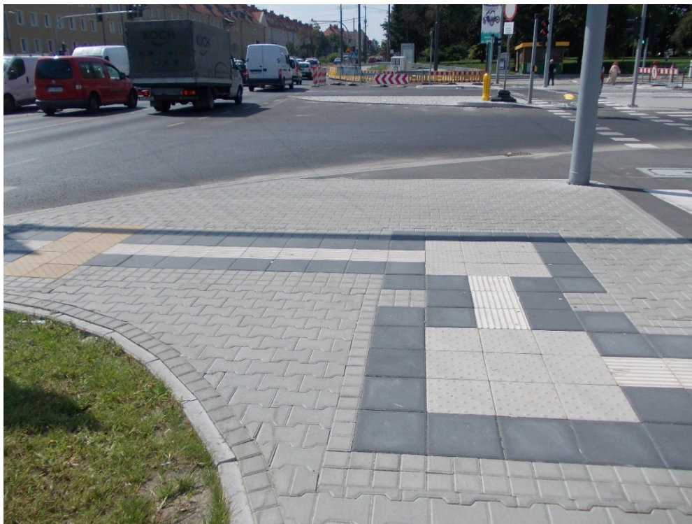
Fot.: System oznakowania poziomego dla niewidomych – węzeł Żeromskiego, Poznań
