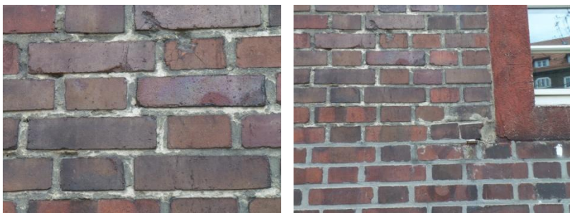
Wapienna spoina pomiędzy ceglami oraz spoina cementowa wprowadzona do poziomu okien parteru.
