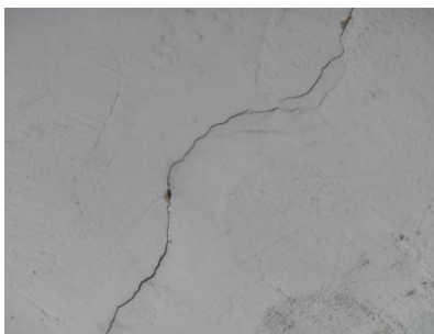
Rysy na ścianie podcienia i na suficie w podcieniu.
