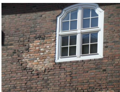
Skutki wadliwie podjętych napraw.
