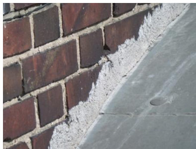
Wyflukane spoiny – widok z góry. Styk opierzenia z murem.
