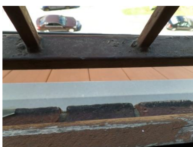
Wyflukane spoiny – widok z góry. Styk opierzenia z murem.
