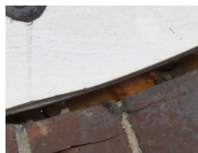
Parapet okien opierzeniem gzymsu. Wyflukane spoiny parapetu okna. Szczelna pomiędzy ramą okna a murem.
