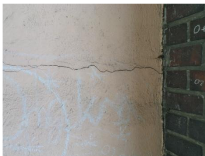
Rysy na ścianie podcienia i na suficie w podcieniu.
