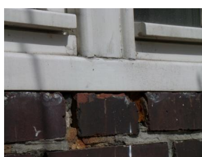
Parapet okien opierzeniem gzymsu. Wyflukane spoiny parapetu okna. Szczelna pomiędzy ramą okna a murem.
