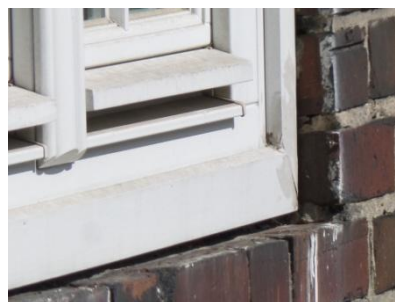
Cofnięcie okien w stosunku do lica muru o około 3-4 cm.
