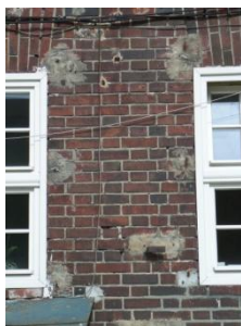
Mocowanie różnych elementów na ścianach : instalacji elektrycznej, kotew, krat itp.
