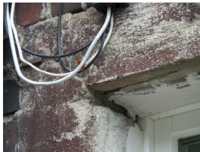
Mocowanie różnych elementów na ścianach : instalacji elektrycznej, kotew, krat itp.
