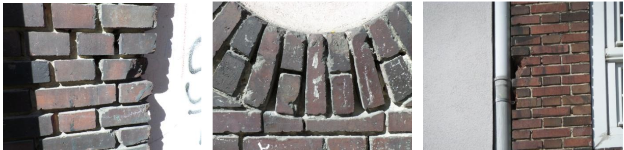
Ubytki fugi oraz cegły w różnych lokalizacjach : cokół, blenda eliptyczna, kanał rury spustowej.
