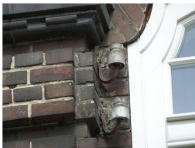
Mocowanie różnych elementów na ścianach : instalacji elektrycznej, kotew, krat itp.
