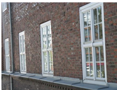
Parapet okien opierzeniem gzymsu. Wyflukane spoiny parapetu okna. Szczelna pomiędzy ramą okna a murem.
