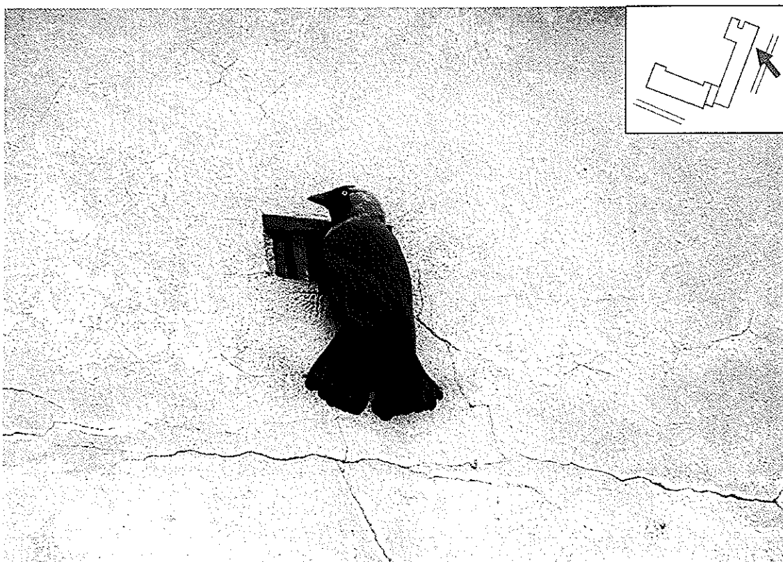
Fot 10. Elewacja frontowa części A budynku Zespołu Szkół Nr 2 w Poznaniu - ściana A1. Kawka przy niezabezpieczonym otworze wentylacyjnym stropodachu (stan na dzień 24-03-2016 r.)
