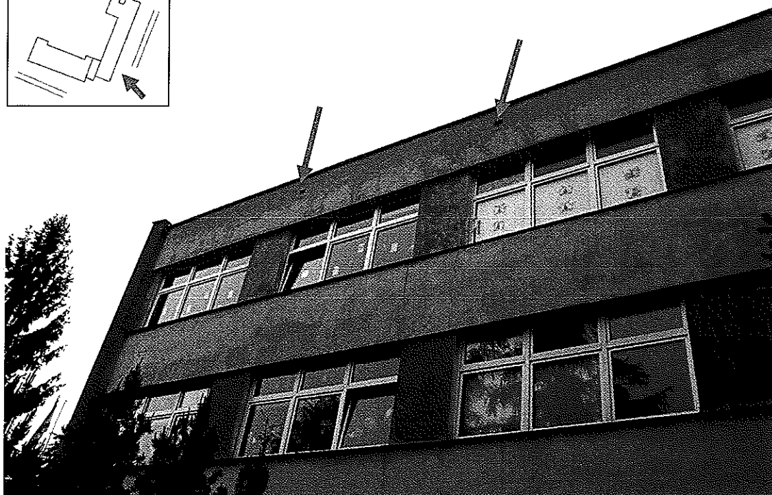
Fot 1. Elewacja frontowa części A budynku Zespołu Szkół Nr 2 w Poznaniu - ściana A3. Strzałkami pomarańczowymi zaznaczono niezabezpieczone otwory wentylacyjne stropodachu wykorzystywane przez kawki. (stan na dzień 16-05-2016 r.)
