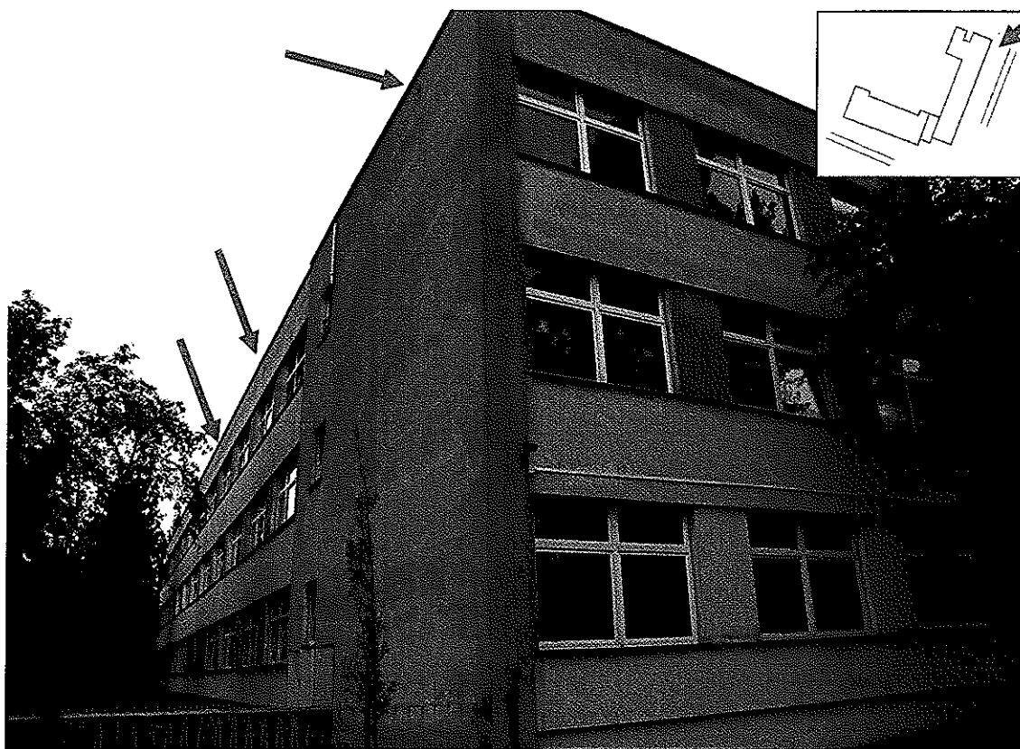
Fot 2. Elewacja frontowa i boczna części A budynku Zespołu Szkół Nr 2 w Poznaniu - ściana A3 i A2. Strzałkami pomarańczowymi zaznaczono niezabezpieczone otwory wentylacyjne stropodachu wykorzystywane przez kawki. (stan na dzień 16-05-2016 r.)
