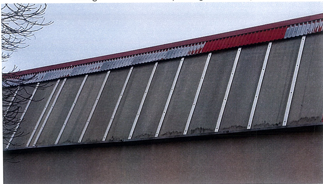
Opierzenie górne okna oraz okapnik dolny
