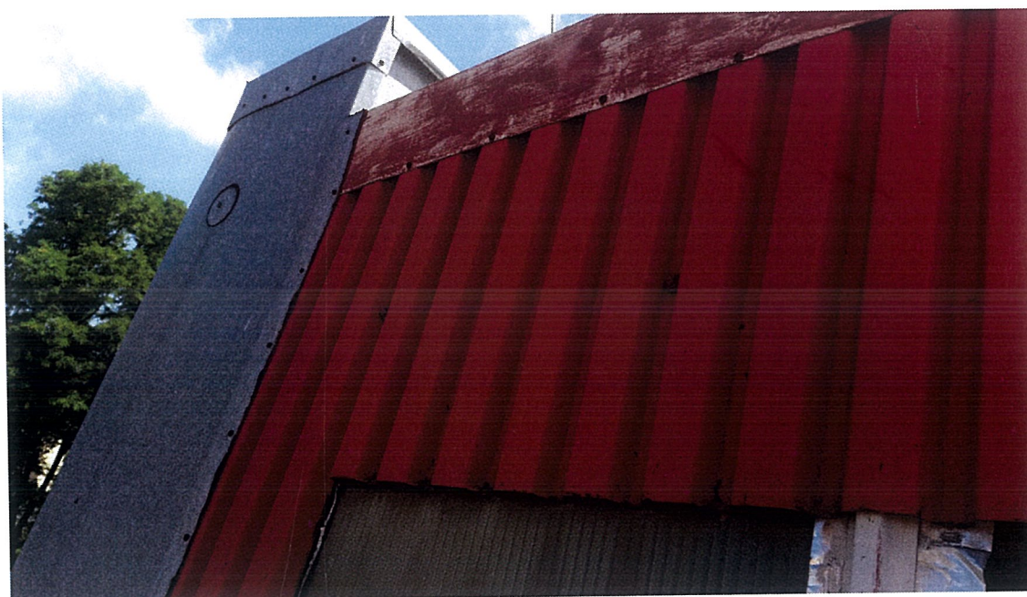
Szczegół opierzenia blaszanego okna
