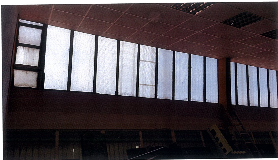
Widok okien od wewnątrz
