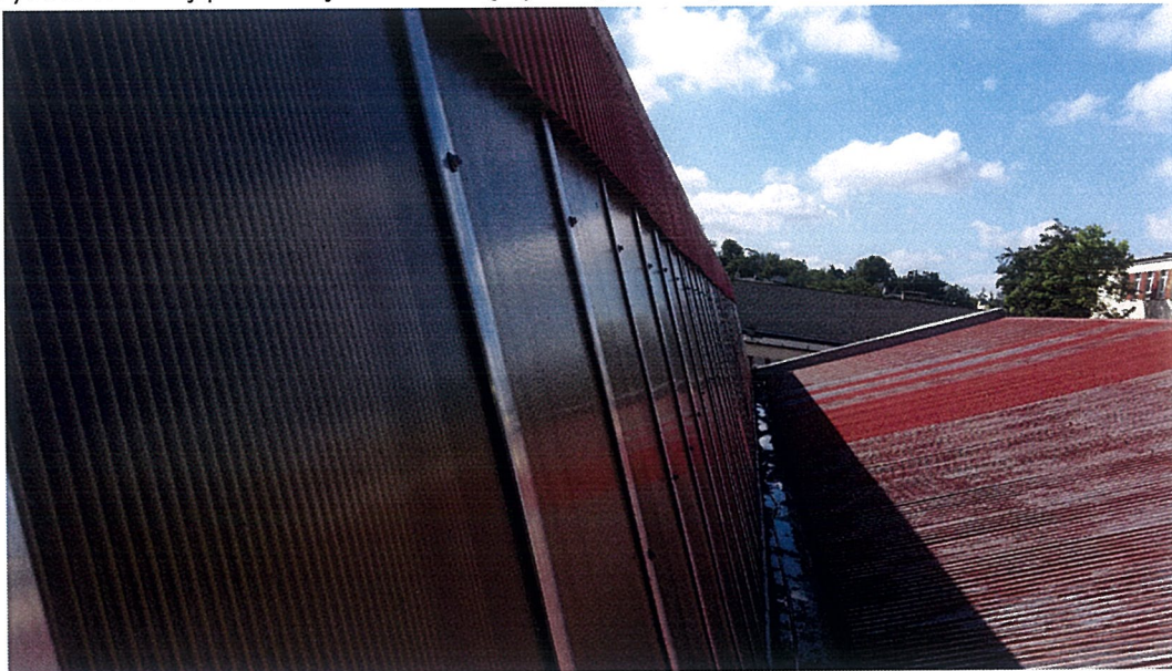
Szczegół osadzenia okna po długości kalenicy
