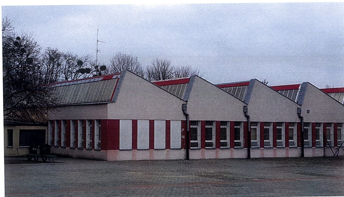
Widok budynku od strony południowej Dach budynku w układzie grzebieniowym
