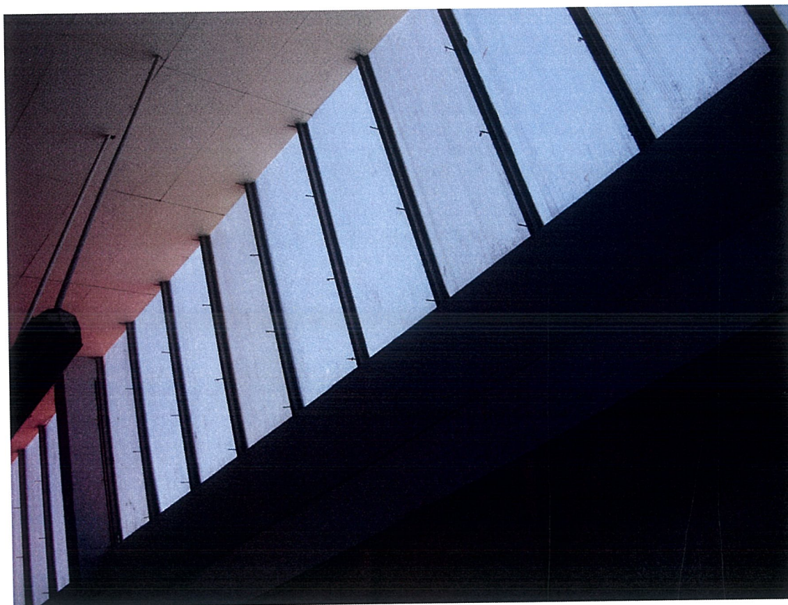
Widok okien od wewnątrz widoczny słupek żelbetowy
