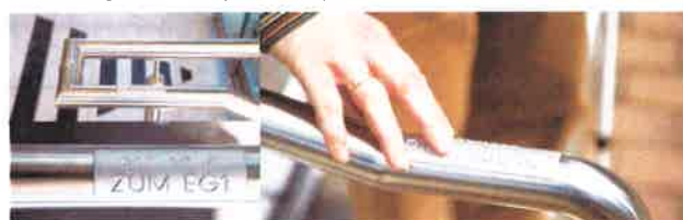
Ryc. 7.11. Oznaczenia na końcach poręczy mogą służyć, jako dodatkowa informacja przy orientacji przestrzennej (źródło: Żelony 2008, s. 16)
