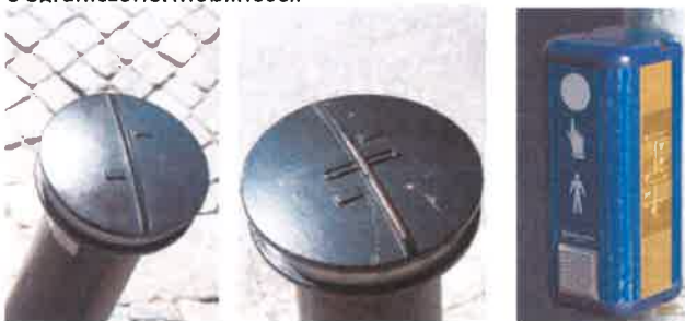
Ryc. 5.7. Schematy dotykowe przejścia dla pieszych mogą ułatwić wytyczenie kierunku przechodzenia przez jezdnię. Schematy przejść: a) bez wypętki, b,c) z wydzieloną wypętką. (zdj. M. Wysocki)
