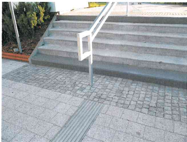
Ryc. 7.7. Pierwszy i ostatni stopień w biegu schodowym może być wykonany w całości jako kontrastowy z innymi stopniami i spocznikiem (autor: M. Wysocki)
